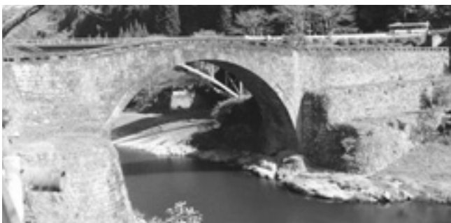
写真2 日本一の単アーチ式石橋 霊台橋
