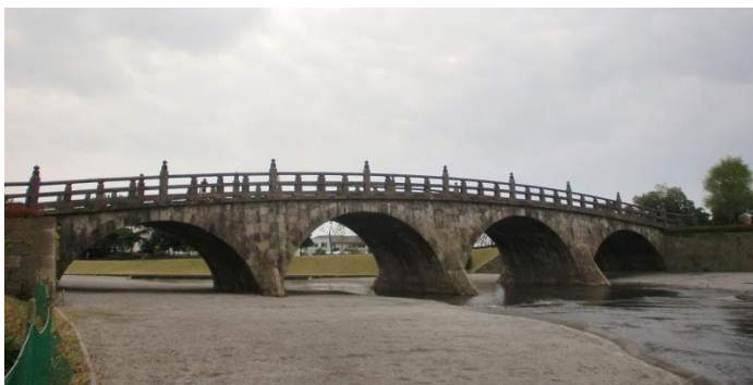
写真3 岩永三五郎による鹿児島甲突川 西田橋
