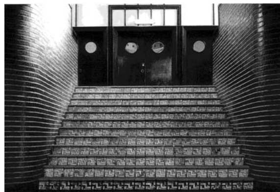
講堂正面・階段の美術タイル・壁タイルの見事さ
